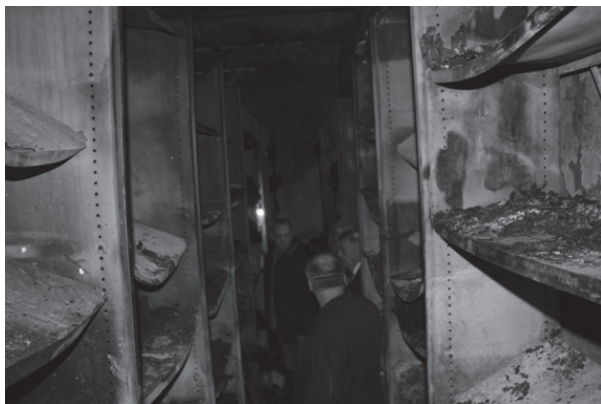
Depo I nakon požara
