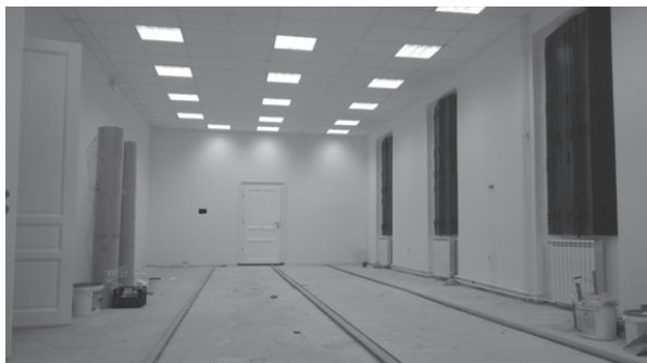
Depo 1 tijekom rekonstrukcije
