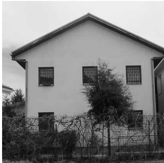
Objekat kancelarijskog prostora Kantonalnog arhiva Travnik
